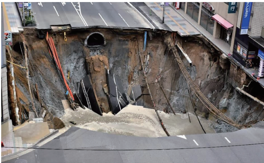
11月8日早上，日本福冈市博多车站前的一条主干道，突然发生大面积塌陷，14米宽的路面被拦腰折断。塌陷现场位于福冈市最大的交通枢纽、博多火车站前400米，当时地下25米处正在进行地铁线的延伸工程。周围有大量商场、写字楼，白天是人流量密集的商务办公区。
