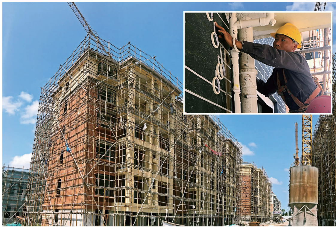
位于马塘镇马新区的文豪佳苑开发项目总投资1亿元,总建筑面积24079平方米,由四幢多层及两幢小高层组成,住宅共计186套。目前正在进行室内装修,预计12月份竣工。建成后将缓解马塘镇城乡居民对于住房的刚性需求,极大改善居住和生活条件,进一步推进马塘镇新区的建设,加快马塘镇城乡一体化建设进程。 记者 蔡珊珊 特约记者 周瑞平 摄
