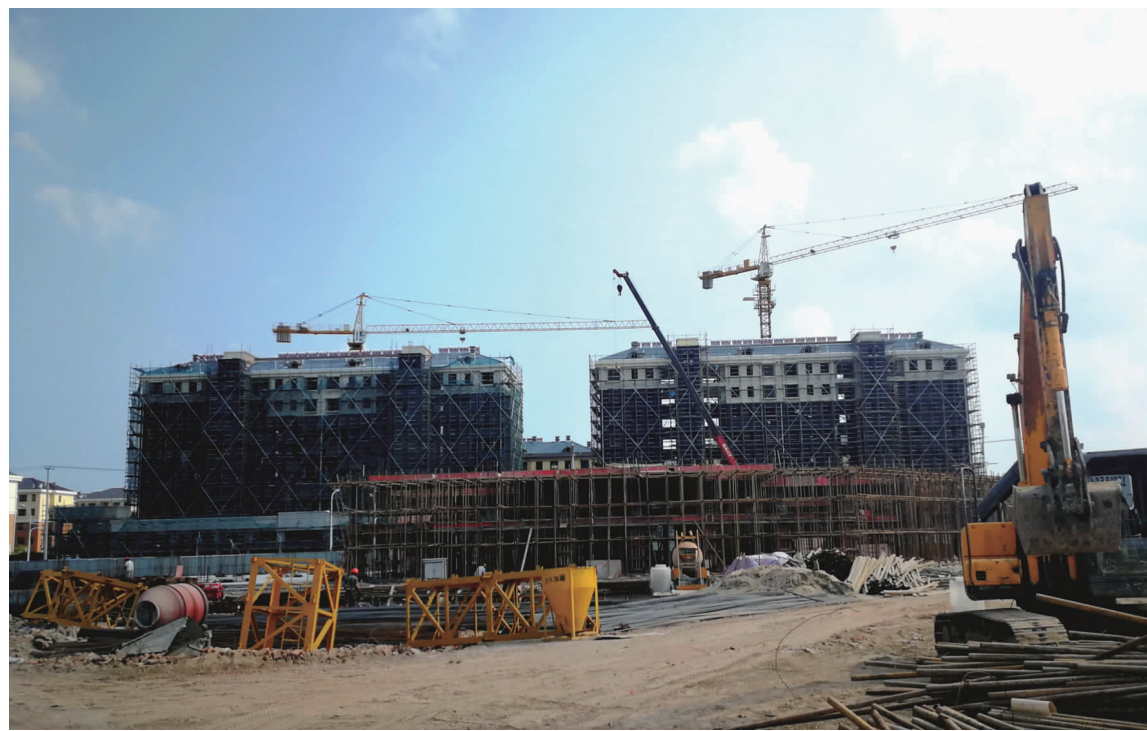
连日来，马塘万颐广场施工现场一片繁忙，工程正在加快建设。该项目计划总投资2亿元，由2幢2层小商业、1幢2层大商业、5层其他商业等部分组成，年底前将完成主体工程。未来，将打造成集大型购物中心、商务酒店、休闲娱乐、国际影院等多种配套为一体的特色商业综合体。记者 王玲玲 特约记者 周瑞平 摄
