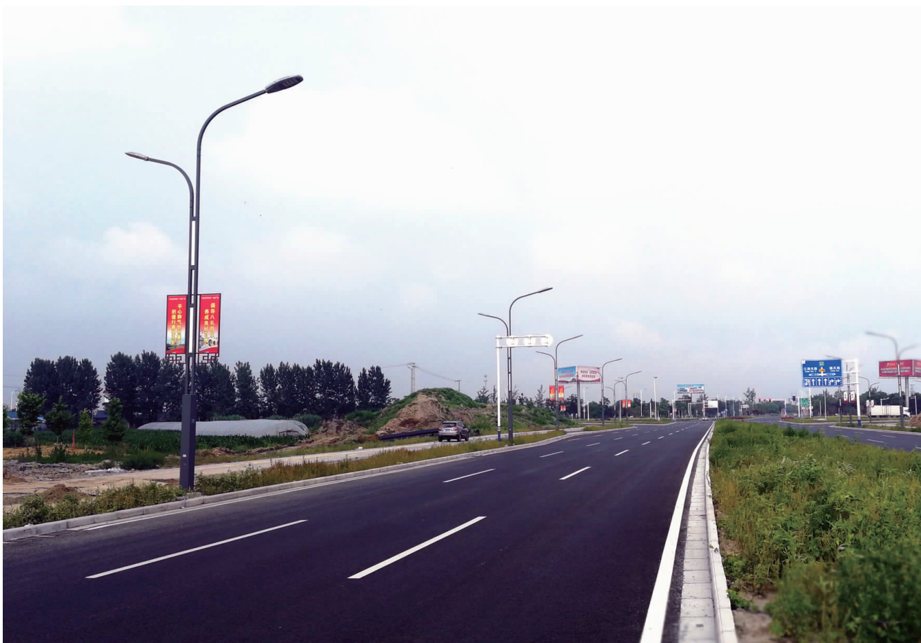
电大路(东二环—东环路)为如东东高速出口的主干道,道路宽50米,长1公里,总投入3500万元。该工程去年3月份正式开工,目前已投入使用,道路两侧正在土地平整,即将开始绿化工程建设。
