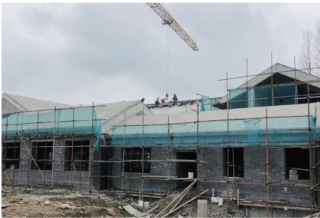
拼茶镇酒文化博物馆位于拼茶镇中市街南侧,为地下一层地上两层框架结构,总建筑面积约2600平方米,总投资约1600万元。目前,酒文化博物馆主体工程已基本完工,正在进行屋面瓦、木结构、楼地面、内墙粉刷施工,预计今年5月竣工,整个项目将在今年年底试运营。 全媒体记者 姜宁惠 张敏 摄
