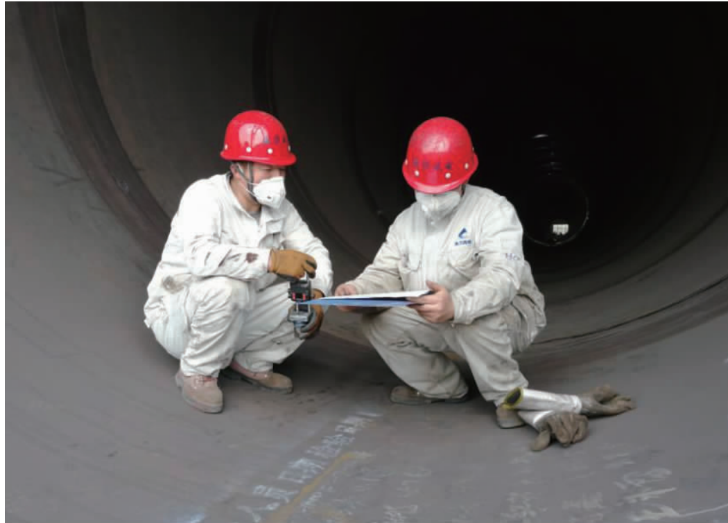
江苏海力风电设备科技有限公司凭借其独有的海上风电配套设备生产技术以及品牌影响力,牢牢掌握市场话语权,今年生产订单已经排满,一季度实现销售近8亿元。图为工人正在为风机塔筒做焊缝准备。
