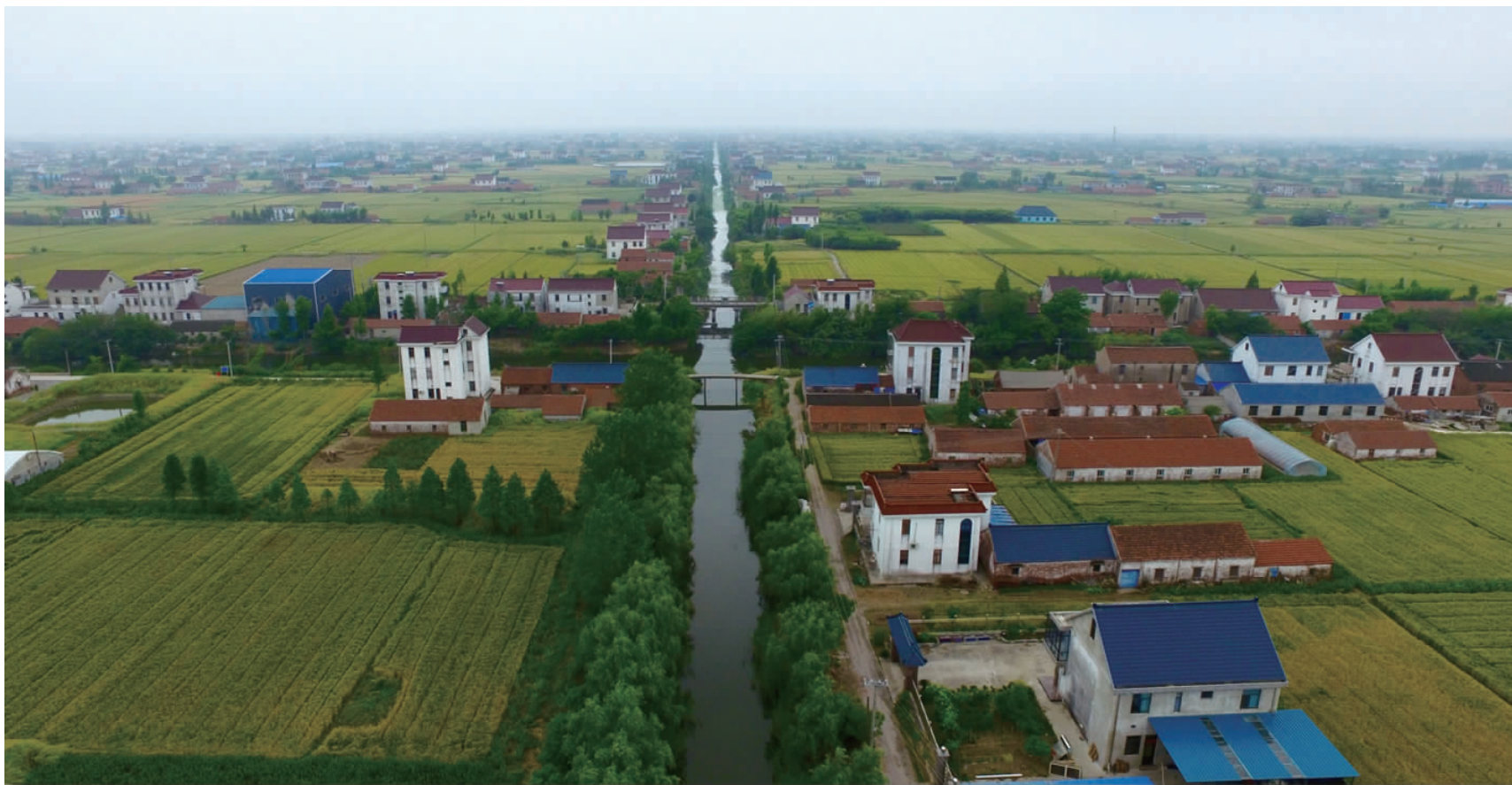
围绕我县打造“河畅水清、功能健全、岸绿景美”的目标,马塘镇今年加快推进河道疏浚整治,计划清理河道90条38.7公里,整治疏浚河道86条53.05公里,建设生态河三条,总长度94.2公里,截至目前,整治任务已完成过半。图为无人机航拍的金华港河,全长4.5公里,是一条三级河道,整治后,河道两侧绿树成荫,河水清澈,人居环境明显改善。
