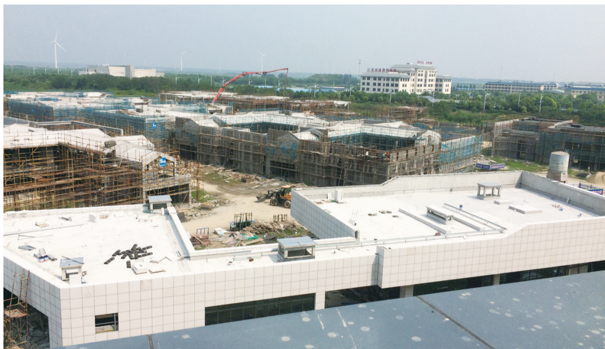
众创智谷和科技城项目一期30多幢楼宇主体工程全部实现封顶。
