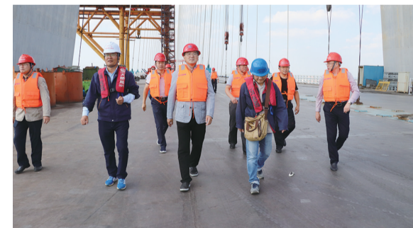
9月23日,县政协主席会议开展专题视察调研活动,实地考察了沪通大桥、海启高速如东段等交通重点工程项目建设。
