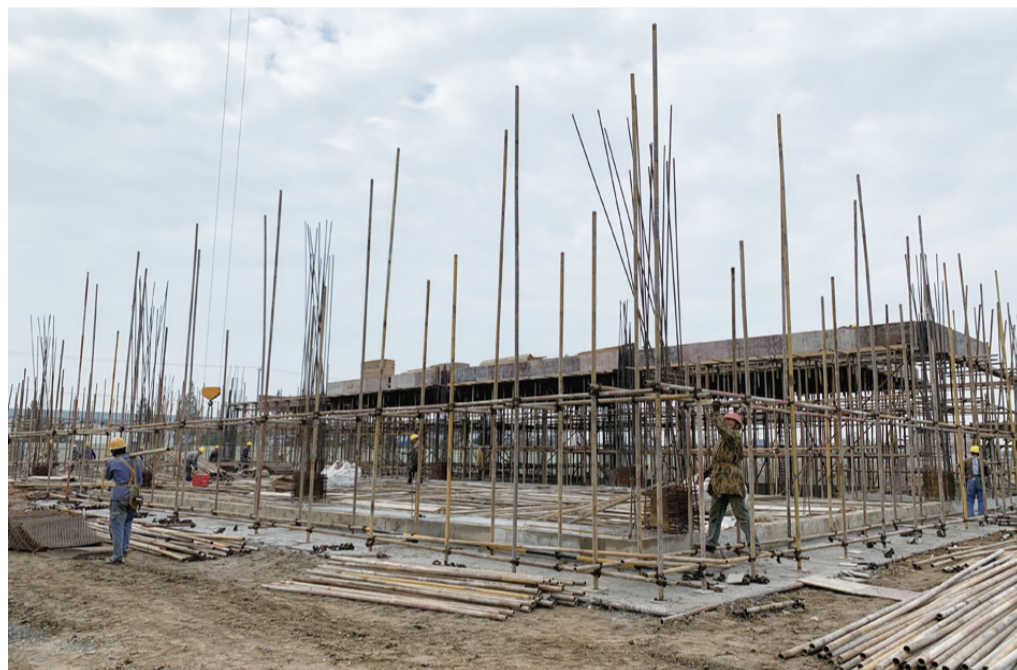
连日来,位于耕茶镇的梦百合家居科技股份有限公司如东分公司健康睡眠家居用品生产项目现场,工人们正在抓紧工期,立木架,扎钢筋,为综合楼搭建排架。一期项目用地25亩,购置各类设备901台套。公司主要产品包括纤维床垫外套、复合床垫外套、模塑枕等。一期项目建成投产后,预计年可新增销售1亿元,创利税960万元。
