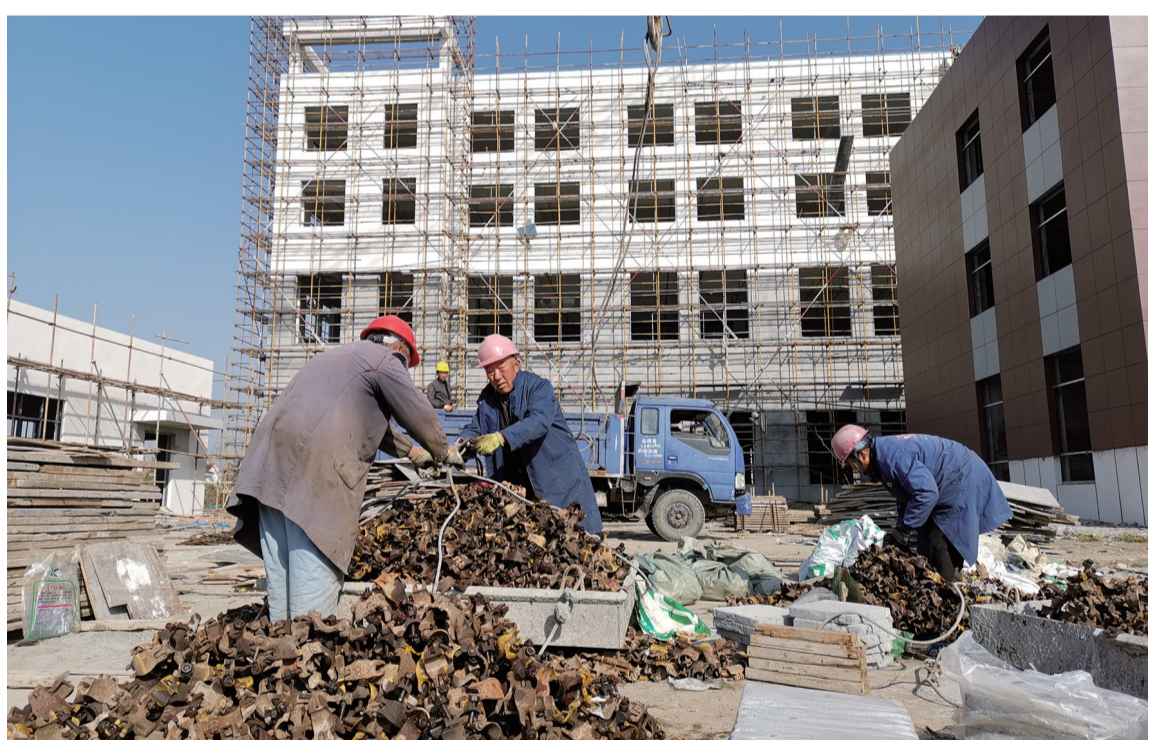
日前,江苏贝耐德电器科技有限公司变频焊接面具及其他产品生产项目正在紧张施工。该项目是新店镇今年开工建设的亿元项目之一,项目购置回流焊接机、超声波清洗烘干一体机、端子机等主要生产设备124台(套),项目建成达产后,可形成年产400万只变频焊接面具、100万只传感器、10万只助听器、10万只智能座便器等产品的生产能力。 全媒体记者 钱海军 陆昊 陈华 摄
