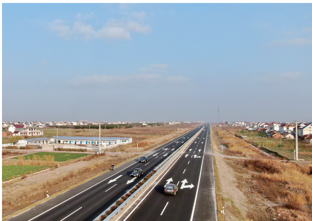
近日,记者从县交通工程质量监督站获悉,334省道如东段已于本月交工通车。该路段于2017年3月开工建设,东起临海高等级公路,经大豫、如东高新区,西到县城东二环,全长16.8公里。道路按一级公路标准建设,设计速度每小时100公里,为双向四车道,建设总投资6.8亿元。 全媒体记者 姚陈 张凯 摄
