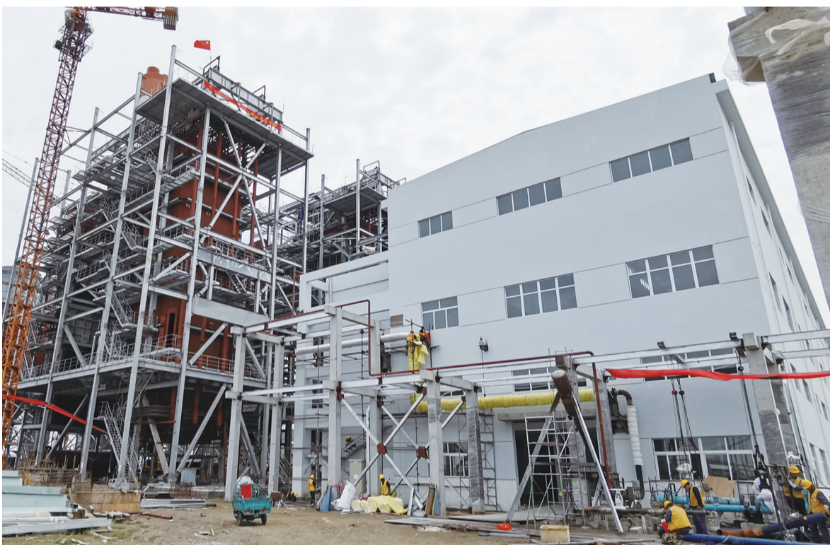
江苏威名石化有限公司是台塑在大陆设立的全资子公司,台塑是全球五大尼龙6原料供货商之一和十大丙烯腈生产商之一。项目一期分为3个子项目,其中,洋口港热电联产一期两台锅炉已正式供热,二期工程正在加紧建设中,有望年底建成投运,另外,环己酮与尼龙6两个项目都处在设备安装阶段。
