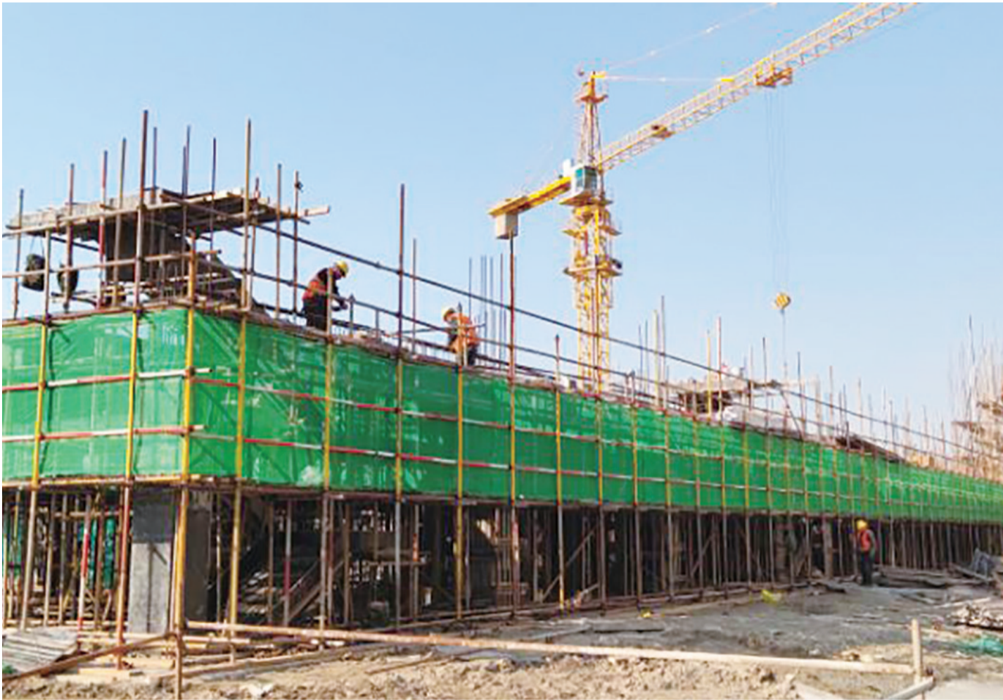
上个月,总投资4000万元的洋口镇中心幼儿园开工建设。幼儿园位于洋口镇洋口新城的核心区域兴洋花园小区内,按容纳5轨15个班级规划设计,总建筑面积8747平方米,是洋口镇规模最大的幼儿园。建成后将为新镇区居民以及沿海经济开发区、小洋口旅游度假区辖区内的近100家企业外来务工人员子女,提供就近的教育配套服务。全媒体记者 张平摄
