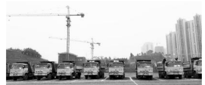
内江市东兴区十三小高新校区建设现场
