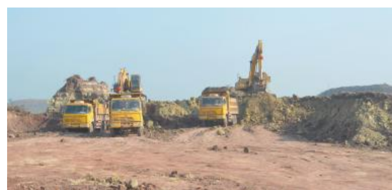
四川·内江新能源汽车产业园项目建设现场
