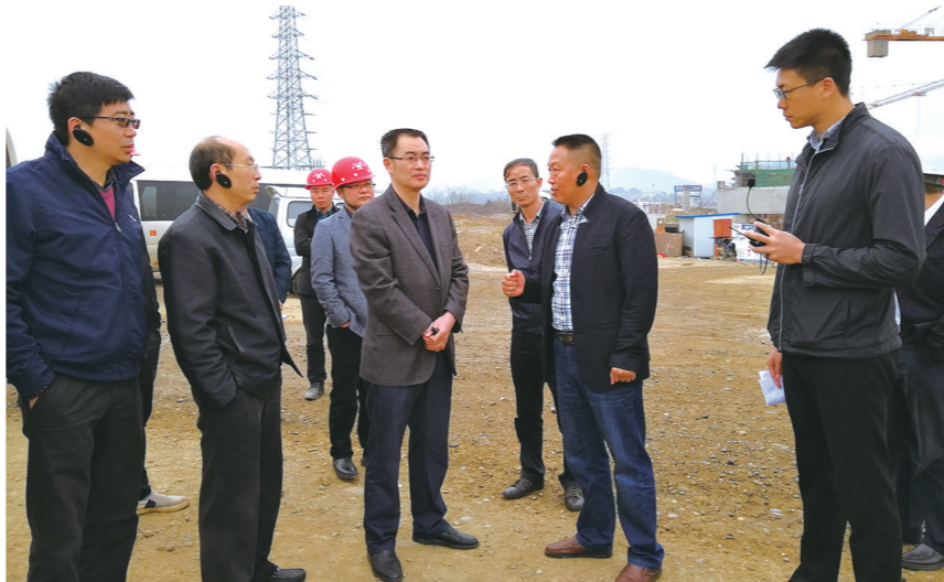
许双全率相关负责人调研南湖路市政道路工程施工现场
