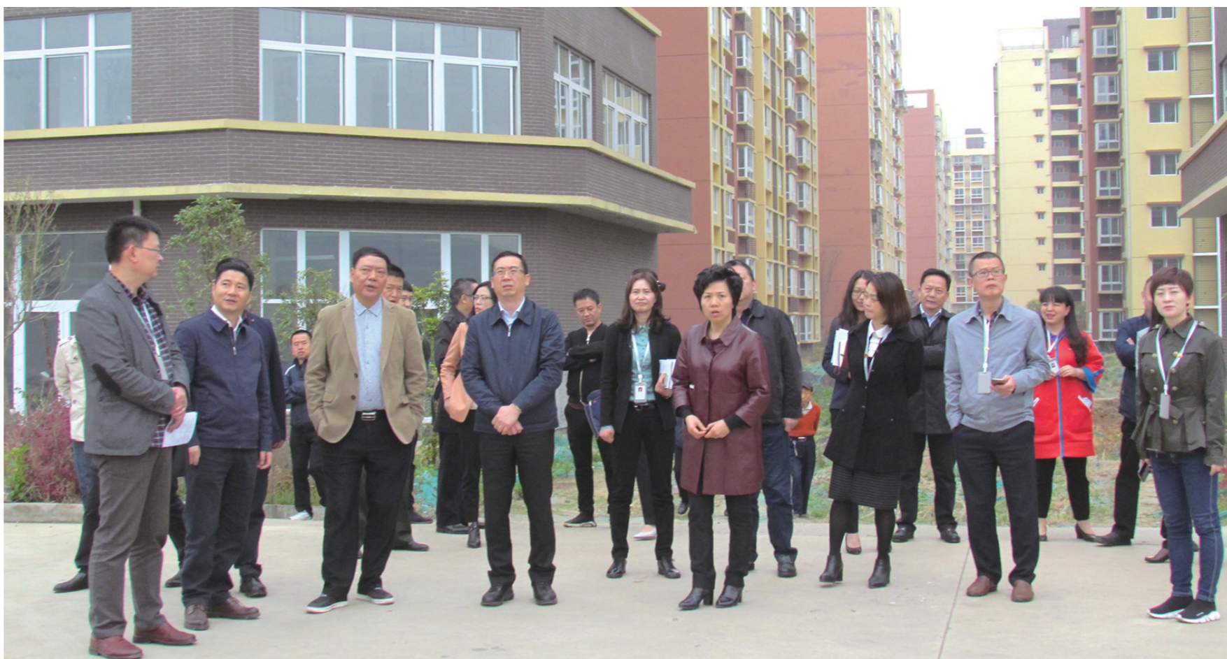
罗文全率相关负责人调研棚改房暨公租房施工现场
