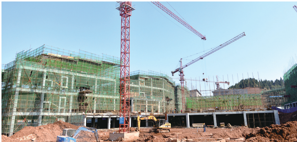
一品天下蓬安会客厅施工现场
