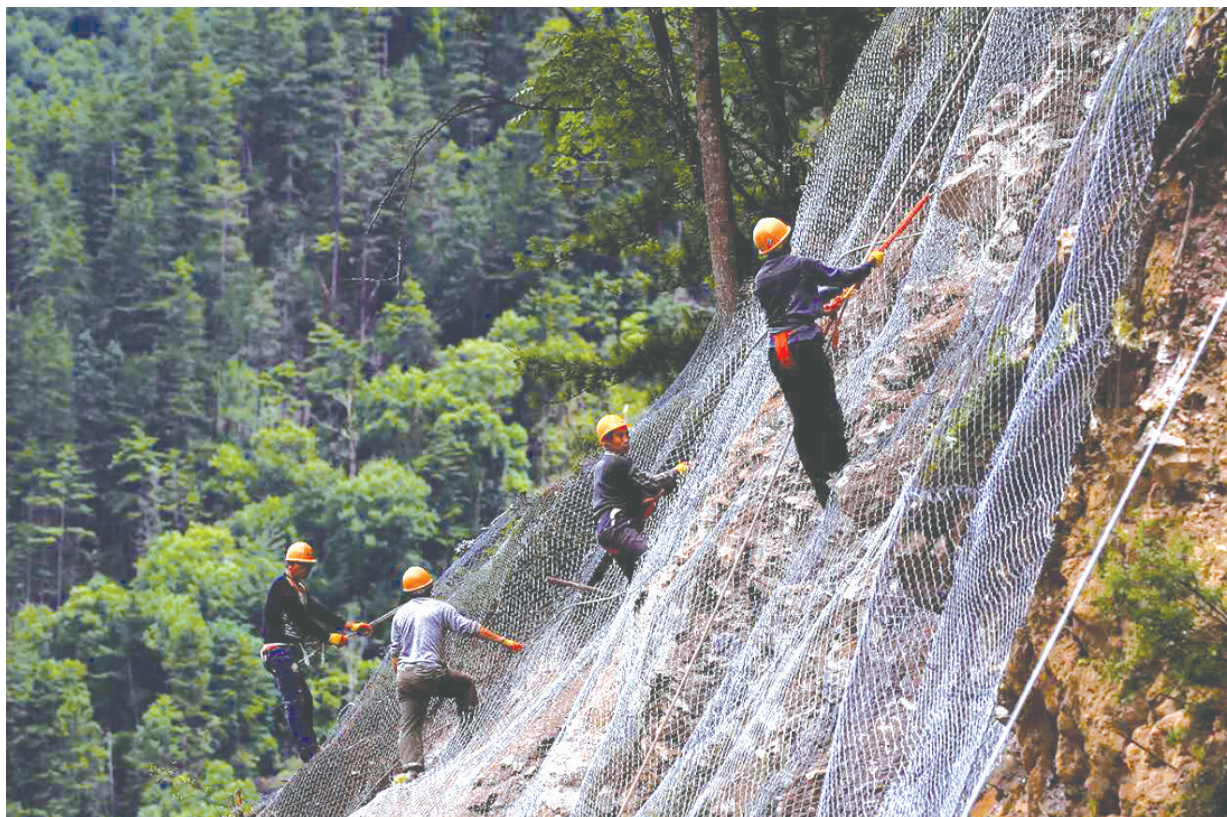
工人正在安装主动防护网
