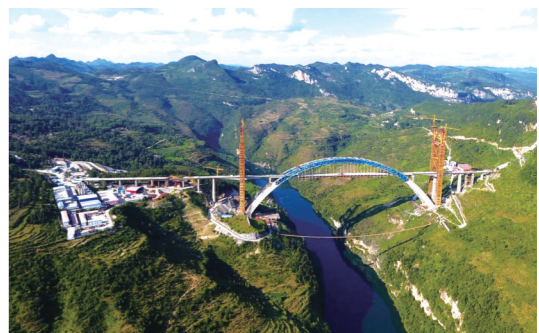
鸭池河特大桥混凝土主梁成功合龙
