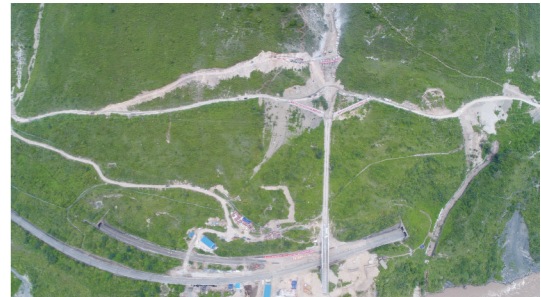
成昆铁路泥石流水害抢险顺利完成
