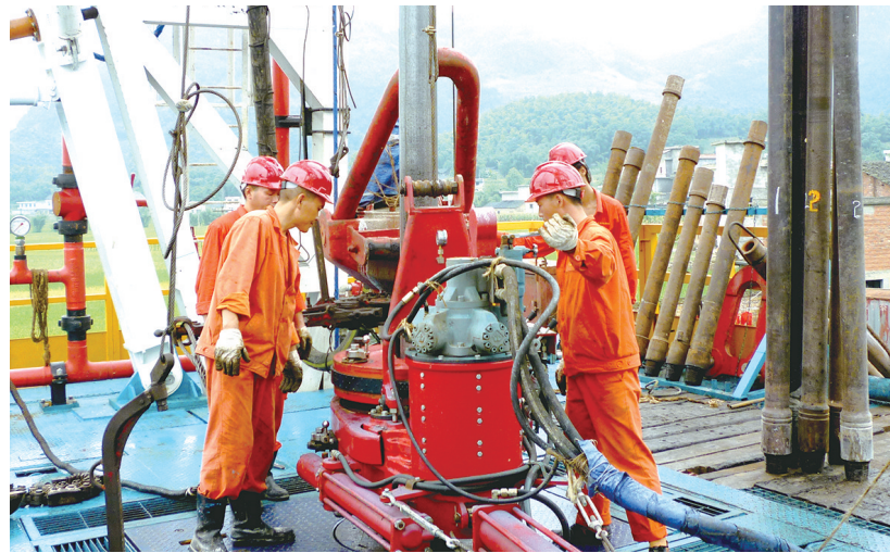
钻井施工现场
