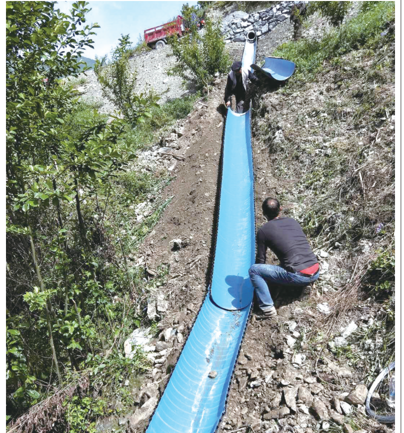
清理“散水归流”波纹管排水沟内的沙石和杂草
