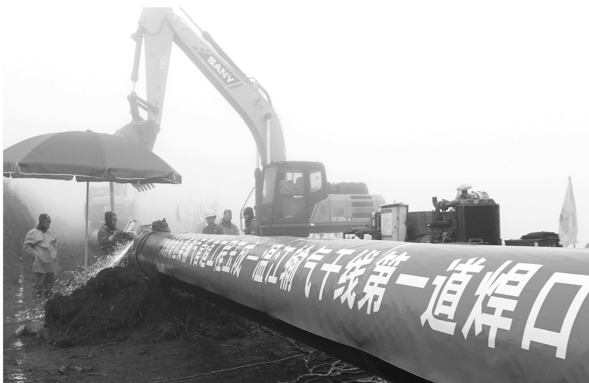
天府新区集输气管道在薄雾中打火
