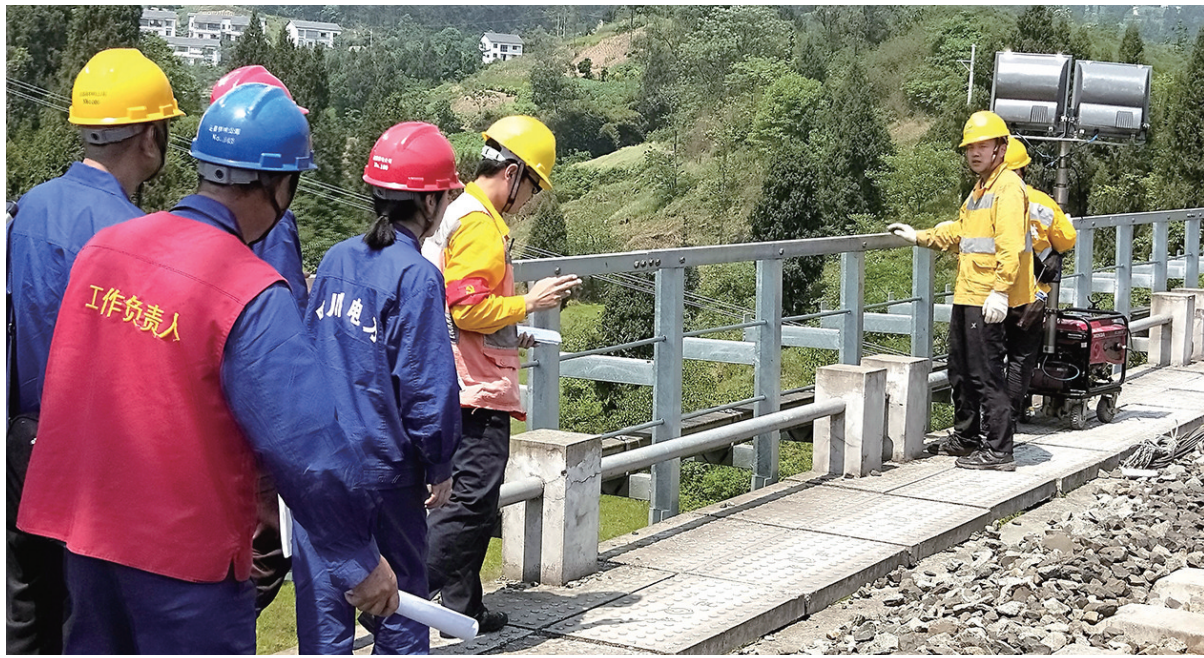
检查线路故障
