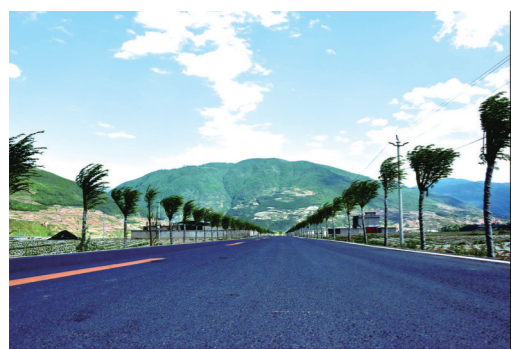
越西交通由原来的处处“断头路”,到现在的乡乡通油路、村村通硬化路
