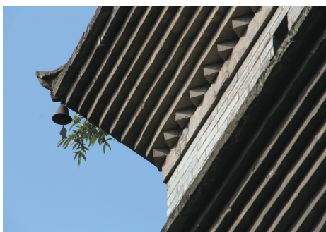
奎光塔局部(叠涩出檐、狗牙砖、铁马)
