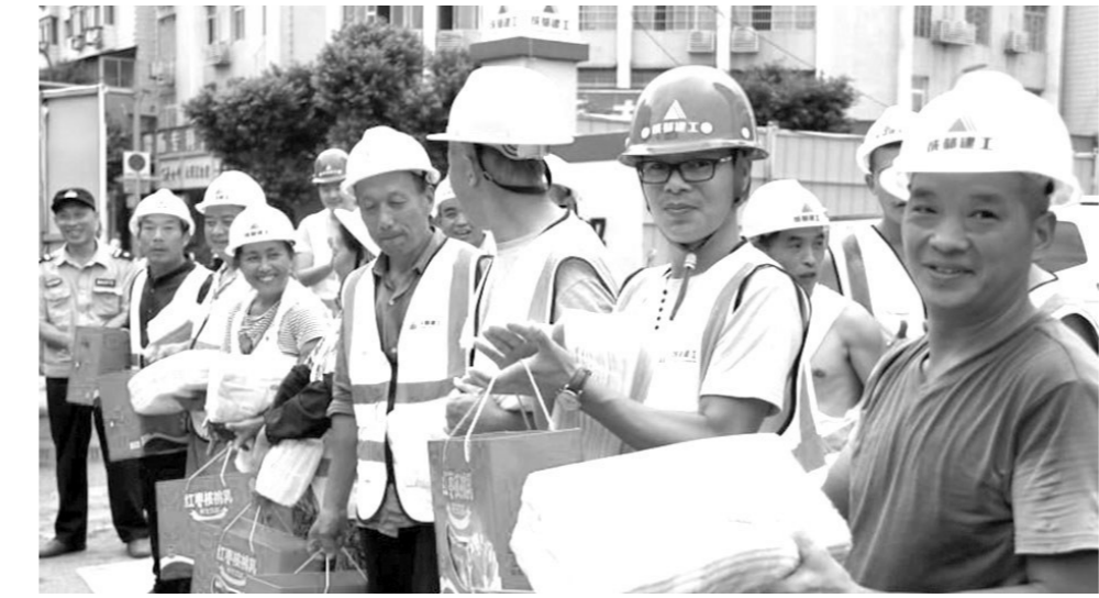
南充市顺庆区总工会为西河中路改造现场工人送清凉
