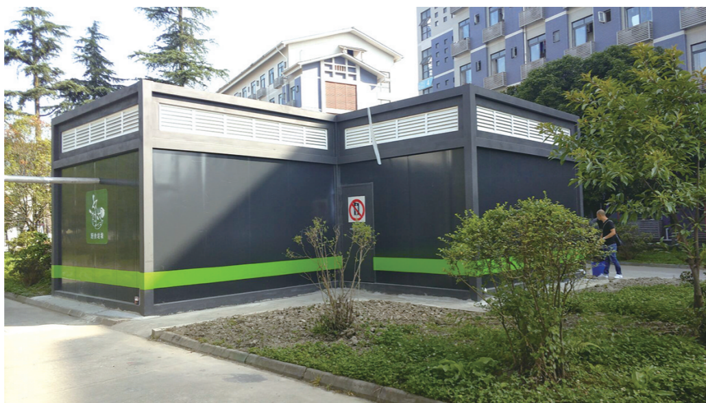
系统升级后的厨余垃圾处理中心
