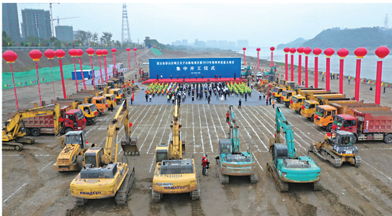
开工仪式现场
