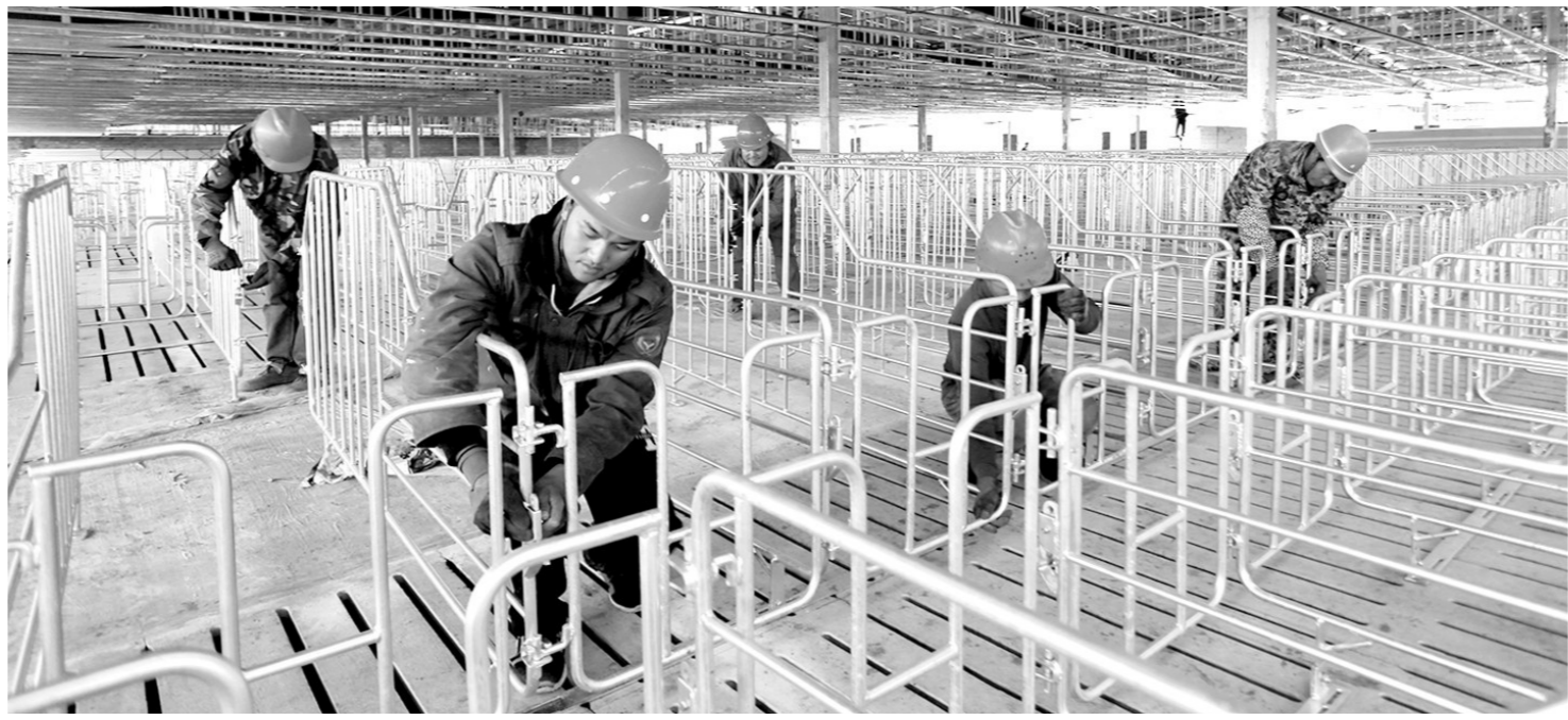
近日,在仁寿县德康慈航现代种猪场项目建设现场,工人们正在加紧安装限位栏。仁寿县德康慈航现代种猪场,占地面积151亩,建成后常年存栏5000头种猪,年产仔猪12万头。目前,项目建设进入设备设施安装阶段,将于今年12月底全部完工。
