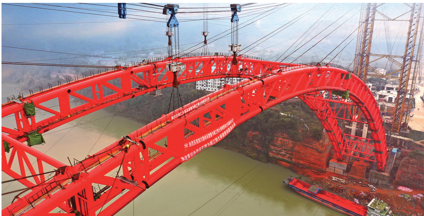
合龙现场(图片由省交投集团提供)
