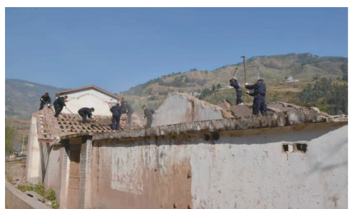
拆除违建现场
