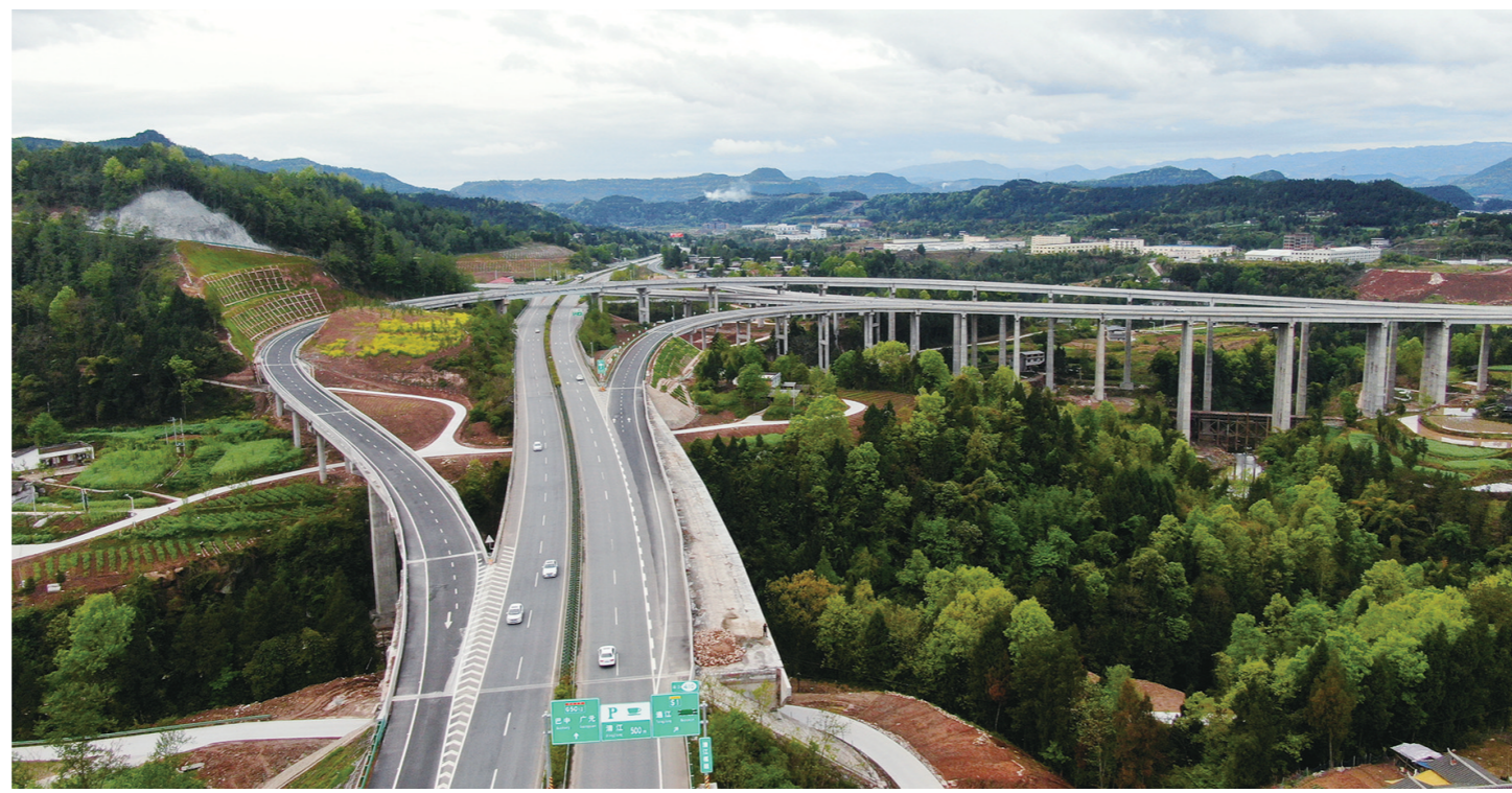
巴中市通江县位于四川盆地的“盆沿”向秦巴山区过渡地带,长期以来主要靠山路与外界沟通。脱贫攻坚战打响后,通江县整合涉农资金,多元化投入,在全县开展了交通大会战,大力修建高速公路和农村公路,打通了“大动脉”,畅通了“内循环”,相继实现了县通高速、乡通油路、村社通水泥路的目标,目前农村公路通车里程达到了6573公里,为该县全面小康提供了基础保障。 图为位于通江县境内,由中国葛洲坝集团承建的巴(中)万(源)高速通江段。 程晓 马亚平 四川经济日报记者 何菊 摄影报道
