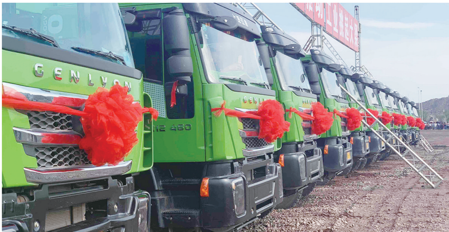
重型机械进入开工现场
