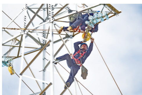
5月15日,工程建设者在巴塘中咱-亚日贡35千伏线路工程23号进行导线展放施工。(陈翔 摄)
