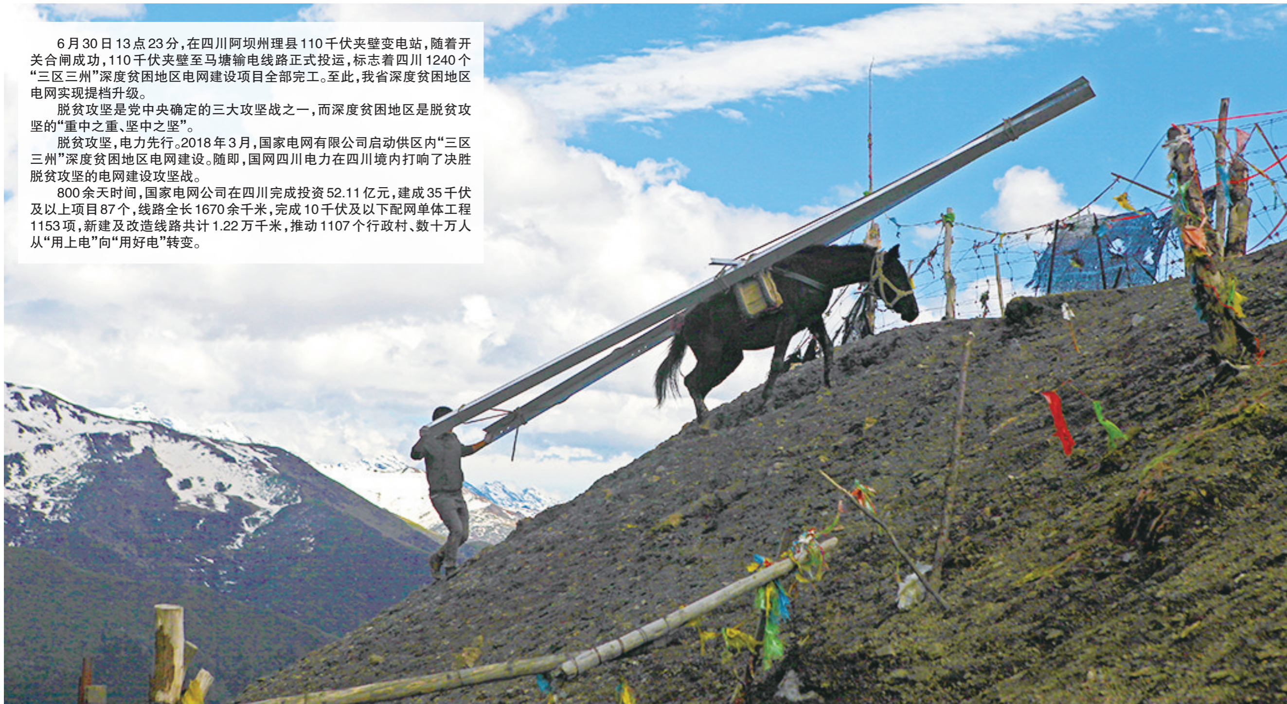
5月19日下午,在国网成都供电公司援建的阿坝夹壁至马塘110千伏线路新建工程中,电力建设者正在抓紧时间利用骡马将塔材运往无人区、重冰区N112号塔位。(王鸿飞 摄)
