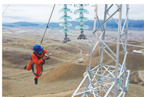
5月23日,理塘-下坝35千伏线路工程16号塔作业现场,施工人员在导线上安装防震锤。(田海 摄)
