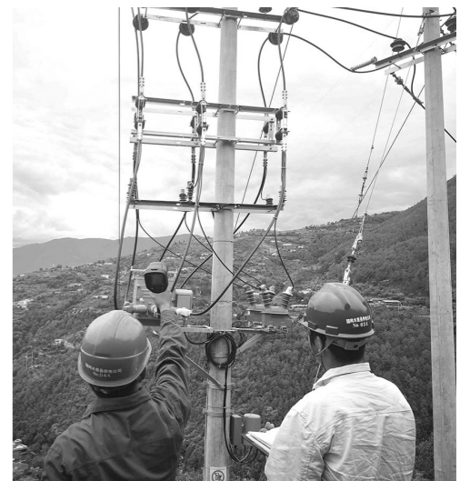
电力工人正在对木里县10千伏乔泥线的12号杆进行红外线测温(国网四川省电力公司供图)
