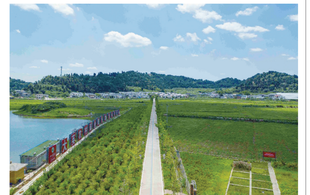
国道350旁大英县产业小环线道路建设助力三农发展
