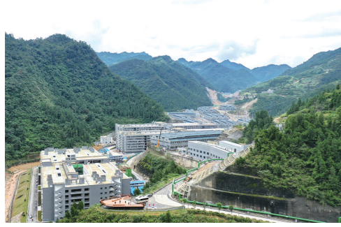
俯瞰郎酒吴家沟项目现场 (杨涛 摄)
