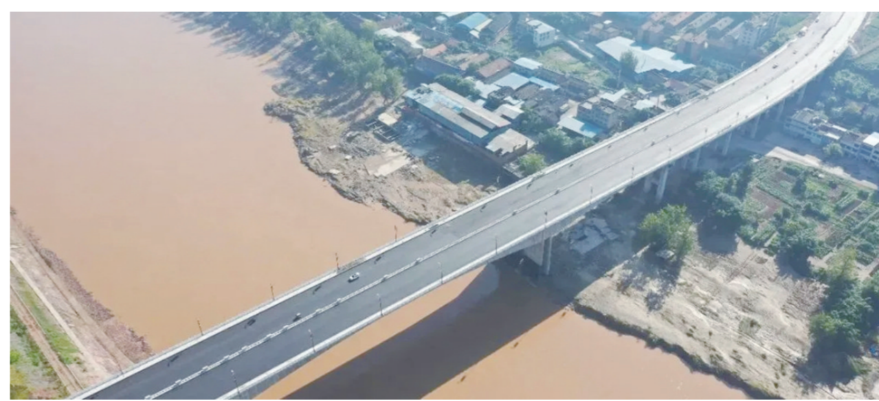
黄荆坝大桥建成通车
