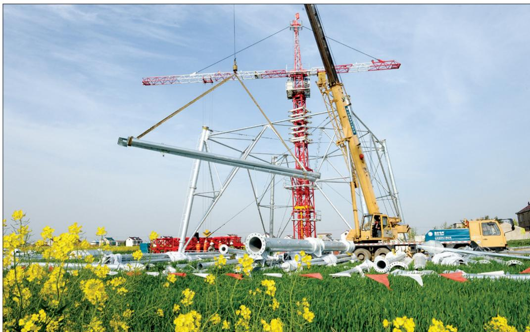
近日,皖电东送1000千伏淮南至上海特高压交流输电工程11号标段101号铁塔正在抓紧施工。该工程全长648.7公里,横跨安徽、江苏、上海三省市。图为施工人员在江苏南通境内进行铁塔吊装作业。 新华社/图
