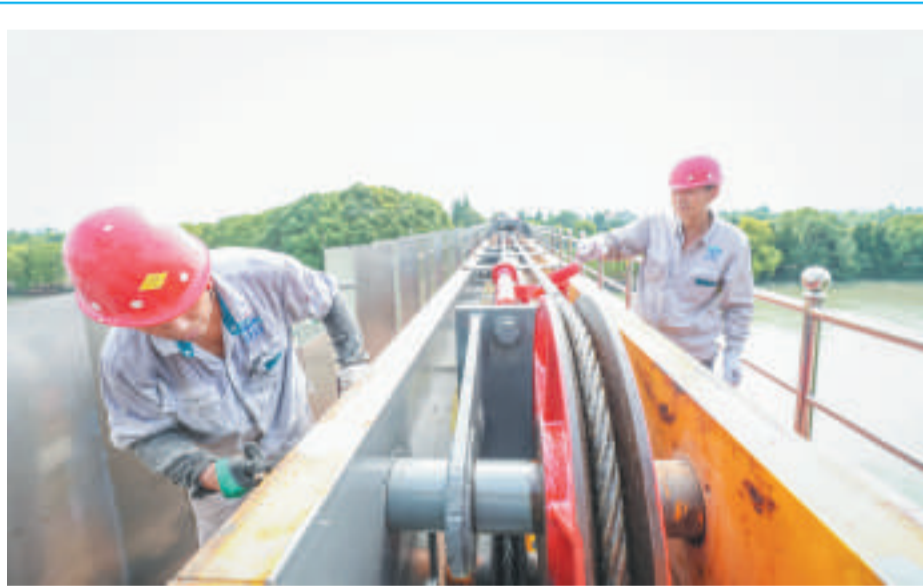
昨日,工作人员在油墩港节制闸维护设备,为防汛工作做准备。 记者 姜辉 摄
