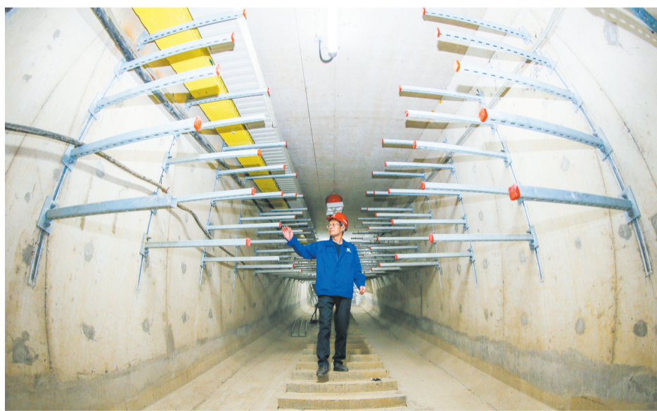
松江南站大型居住社区综合管廊一期工程已基本完工,共建设综合、电力、燃气、污水、初期雨水、雨水和地下空间7座管廊,投入运营后将服务松江南站大居各小区。图为工人正在管廊内部巡查。
