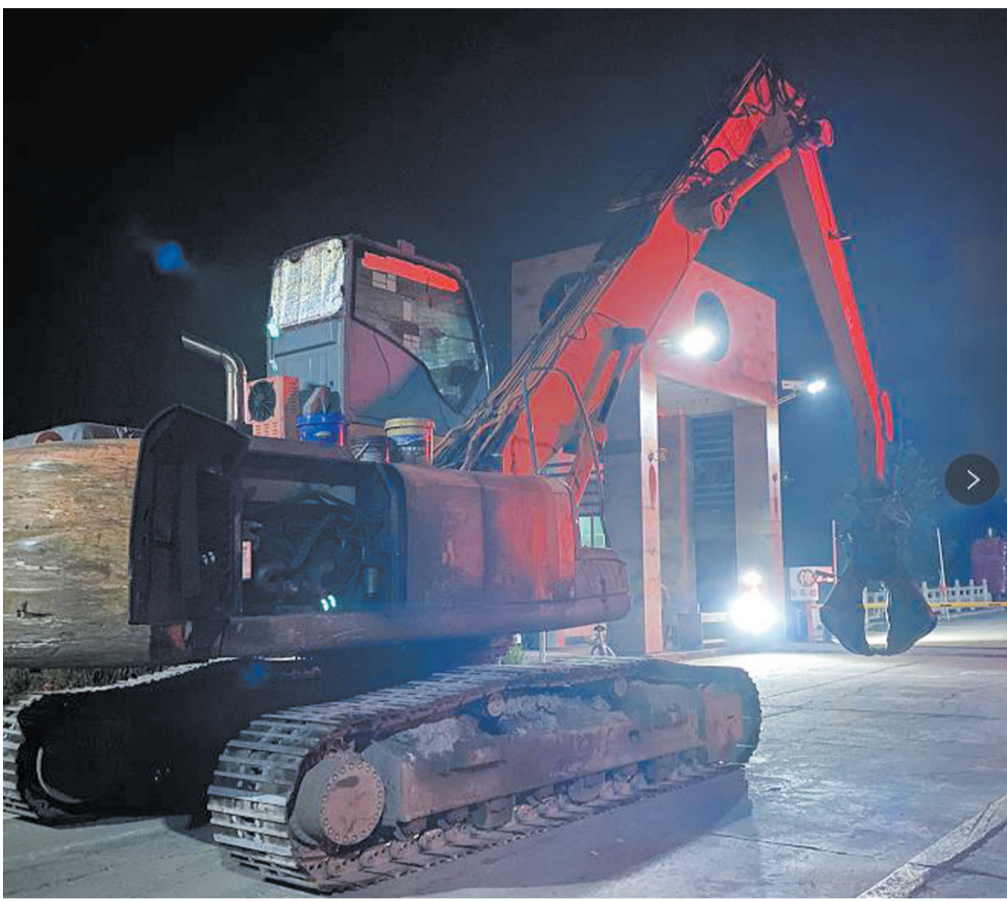
因被执行人暗中使“绊子”,半夜11时多大型挖掘机仍无法离开被执行厂区。区法院执行局供图
