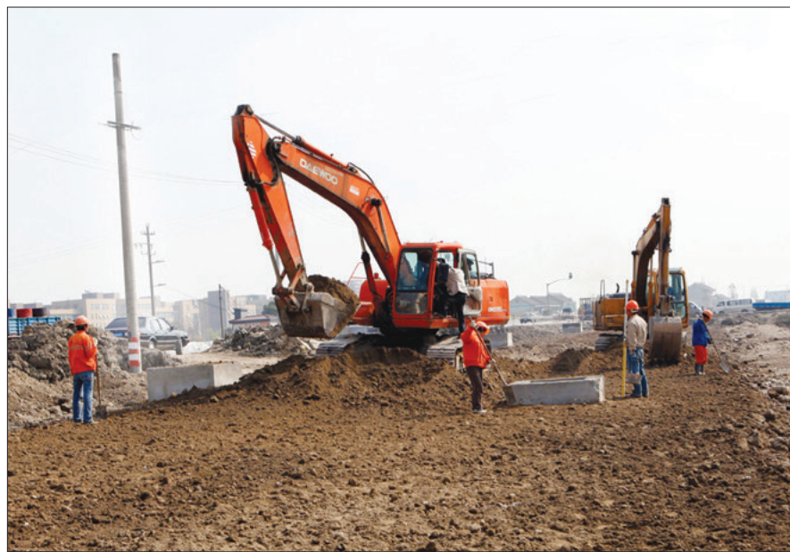
全长5.49公里的卖新公路改扩建工程正在加紧施工中。该工程由凯达公司施工,路段西起沪松公路,东至九新公路,跨A8、A5两条高速公路,由地面道路和连续高架桥组成。计划今年年底完成。改扩建后,卖新公路由双向2车道增为双向6车道。 记者 岳诚 摄
