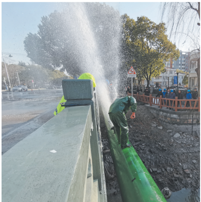
思贤港桥水管阀门爆裂,工作人员在冷水中抢修。
