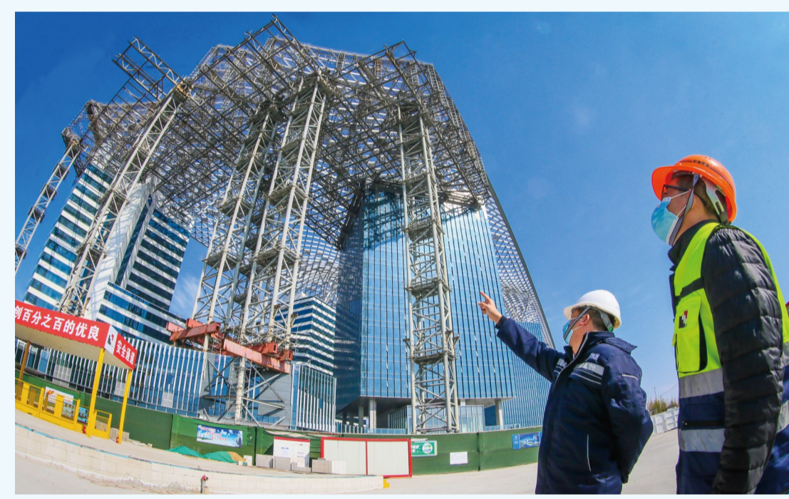
昨日,重点建设项目——G60科创云廊的参建单位工作人员正在对塔吊、施工电梯、用电设备、消防设施等进行检查,做到早发现、早整改,为安全复工做好准备工作,确保项目建设和有序推进。 记者 蔡斌 摄
