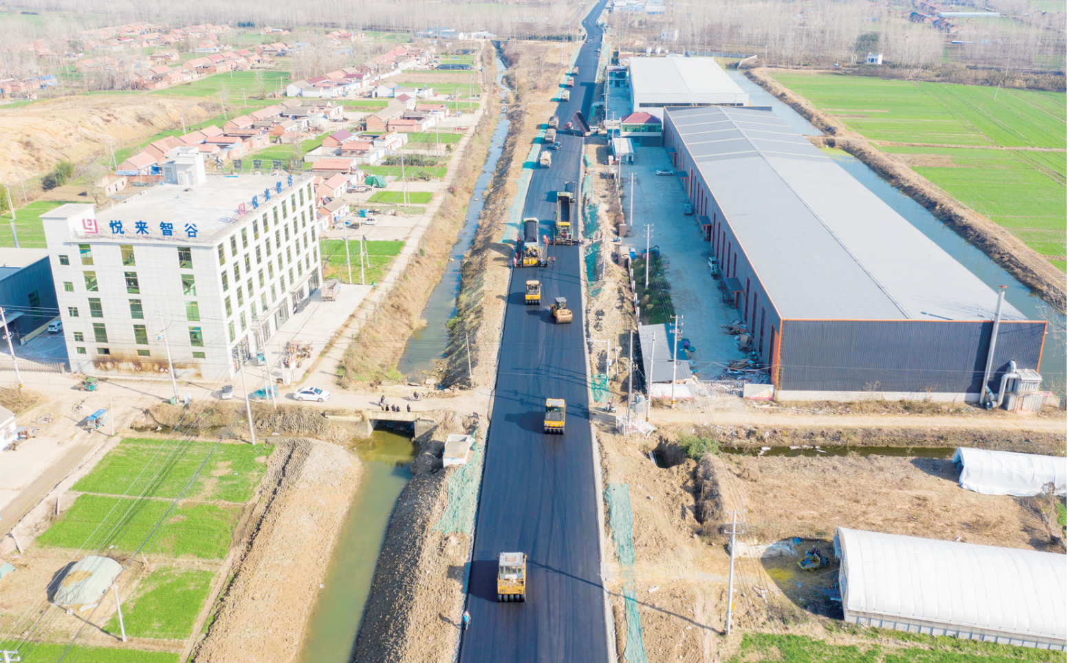
建好农村道路助力乡村振兴 12月4日，在沭阳县沭悦线道路改造工程施工现场，在压路机、摊铺机、运送工程车等配合下，施工人员各司其职，忙个不停。该工程为沭阳县2022年为民办实事项目之一，起点位于宿豫区与沭阳县交界处，沿现有老路向东延伸至耿圩镇，改造路段长8.8公里，计划于今年12月底完工。该路段修复以后，将大力提升农贸物资运输效率。 祝潮洋 韩元元 韩敏 摄
