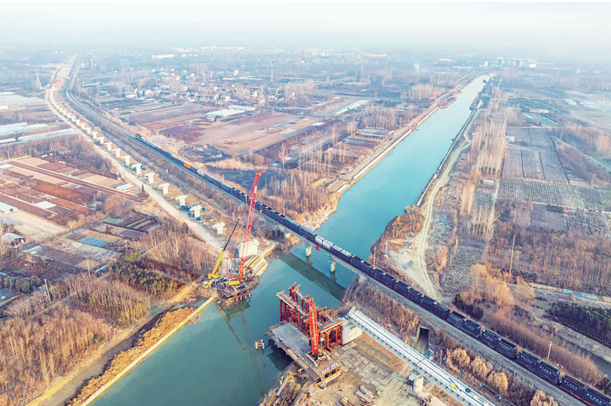
1月3日,位于沭阳县境内的宿连航道整治配套新长铁路改建工程建设工地,工作人员冒着严寒加紧施工。数台大型机械相互配合,施工现场一片繁忙景象。
