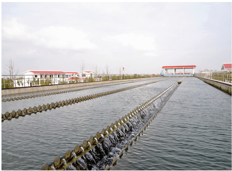
新建的明湖地面水厂
