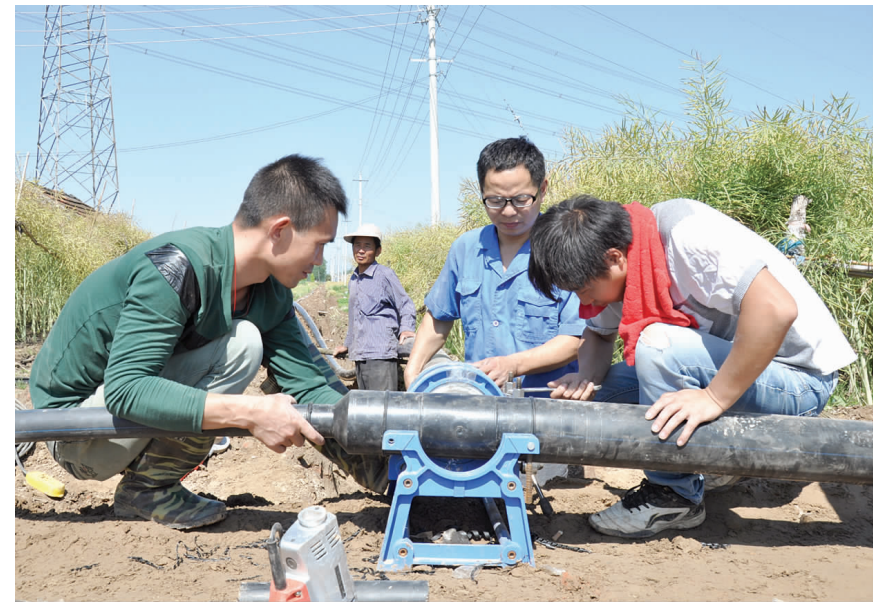
洋马镇在铺设入户管网
