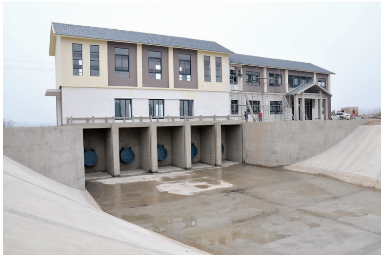
即将竣工的千秋翻水站
