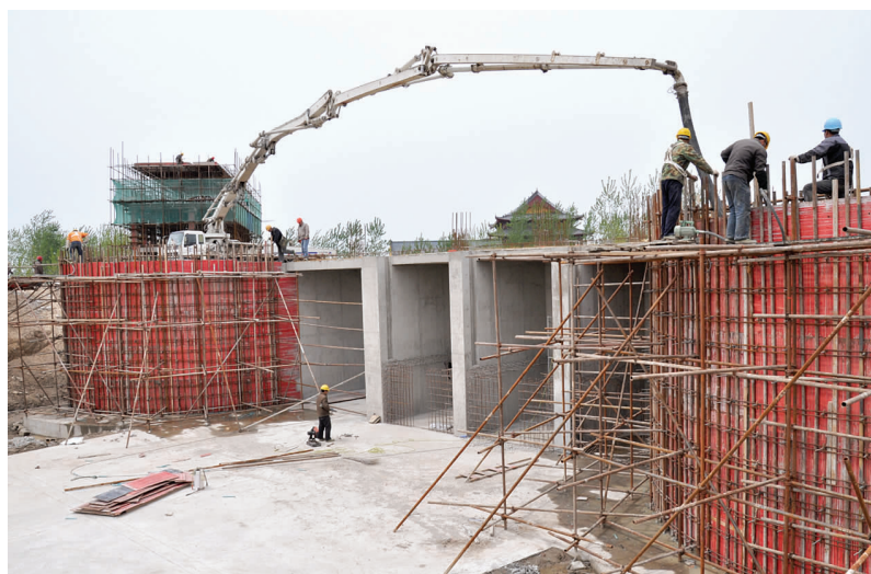
建设中的朱港泵站
